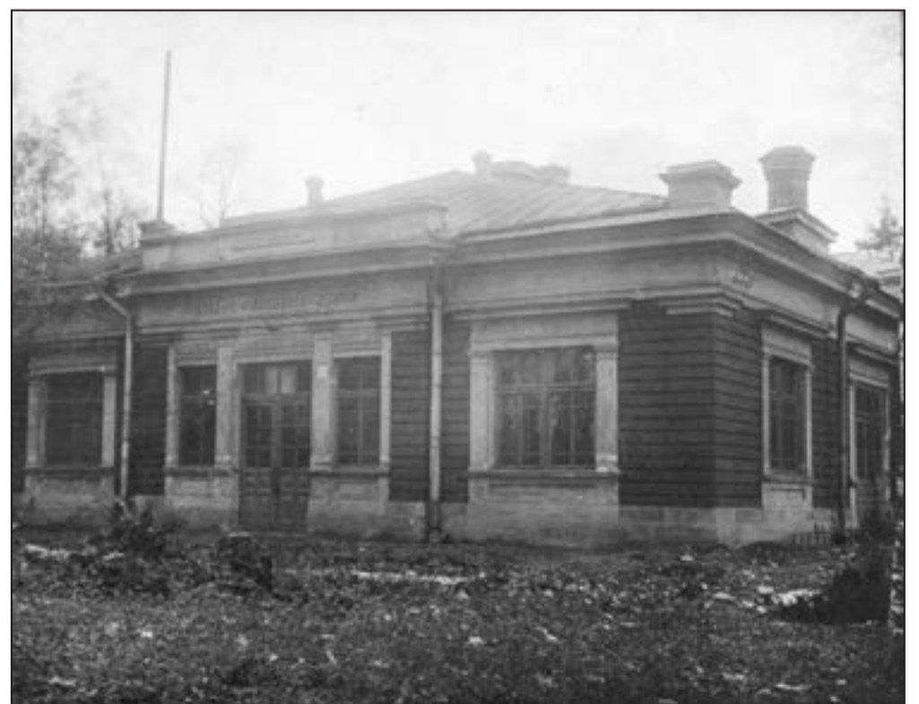
Здание гатчинской электростанции. Снимок сделан «после революции в период до 1927 г. Фасад со стороны дворца, напротив Арсенального каре. Вторая сторона выходит на Липовую аллею»
